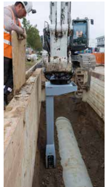
Kabel- und Rohrleitungsbau
