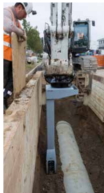
Kabel- und Rohrleitungsbau
